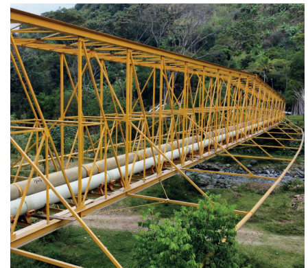
Viaducto sobre el río Combeima
