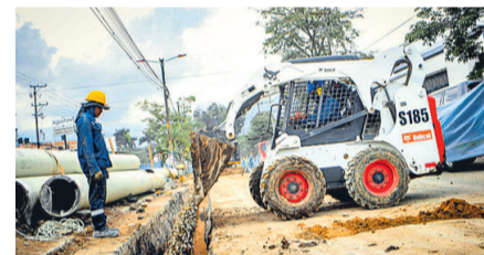
Se instalaron a través de plusvalía entre entes privados y públicos siete kilómetros de tubería conectando los tanques Sur y Zona industrial.
