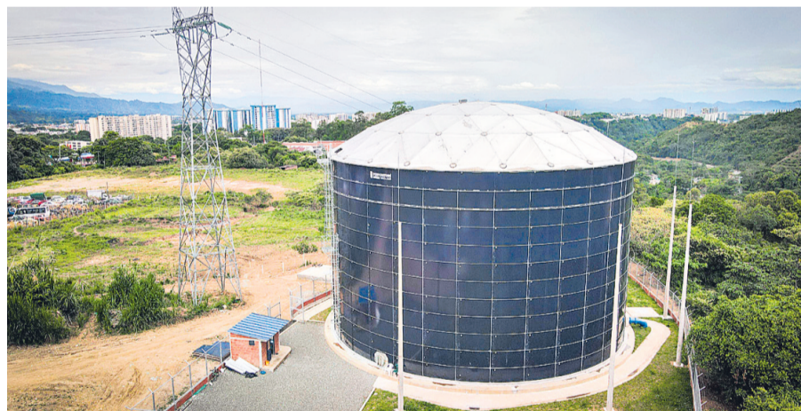
El tanque Zona Industrial, o Fiscalía, tiene una capacidad de 10.000 metros cúbicos.
