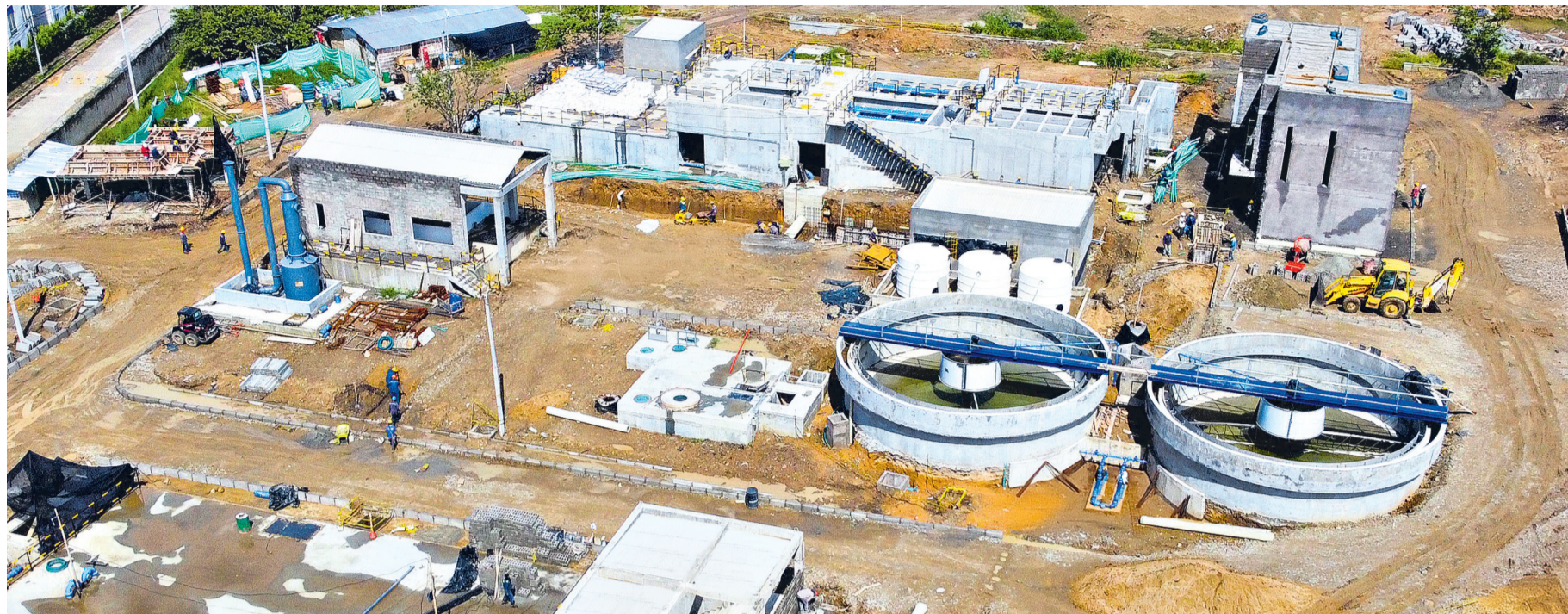
Se avanza en la construcción de la planta de tratamiento de agua potable en Boquerón para ofrecer este servicio a más de 60.000 ibaguereños. / Fotos: Archivo Ibal.
