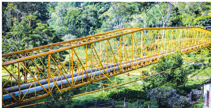
Son 15 viaductos los que garantizan la funcionalidad del segundo acueducto.
