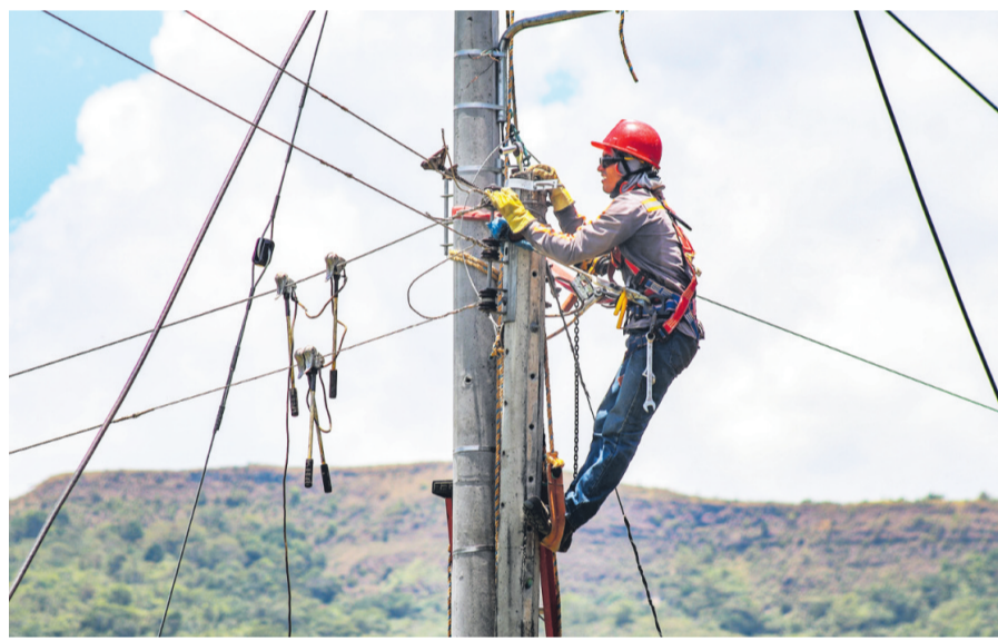
Celsia avanza en el trabajo de modernización, de instalación de mejores equipos y de adecuación de conexiones en la región.
