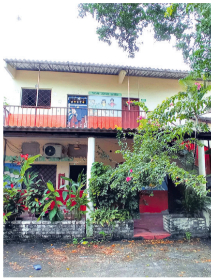
Antes y después de la remodelación la institución educativa La Paz No. 1 de Flandes, sede San Luis.
