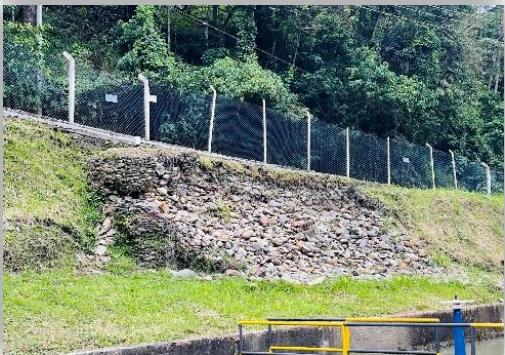
Se recomienda adelantar las actuaciones administrativas necesarias para la reparación y reinstalación de los gaviones que se encuentran actualmente deteriorados o en mal estado, dado que su función es crítica para la protección de taludes y la contención de erosiones que podrían comprometer la infraestructura de la bocatoma Combeima, como la seguridad del personal operativo.
