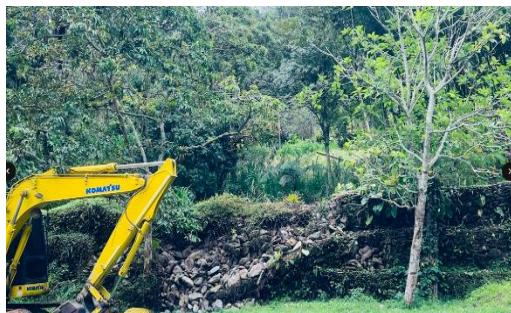
Asimismo, es fundamental informar formalmente al área supervisor del contrato asociado a la maquinaria tipo retroexcavadora, sobre el daño ocasionado a uno de los gaviones, esto con el fin de establecer las responsabilidades correspondientes y definir las acciones correctivas o compensatorias que se deban aplicar conforme a lo estipulado.
