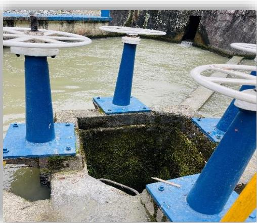
Se sugiere instalar rejillas de protección en los pozos de desagüe de las válvulas de lavado de los desarenadores, de los cuales existen cuatro (4) en total.
